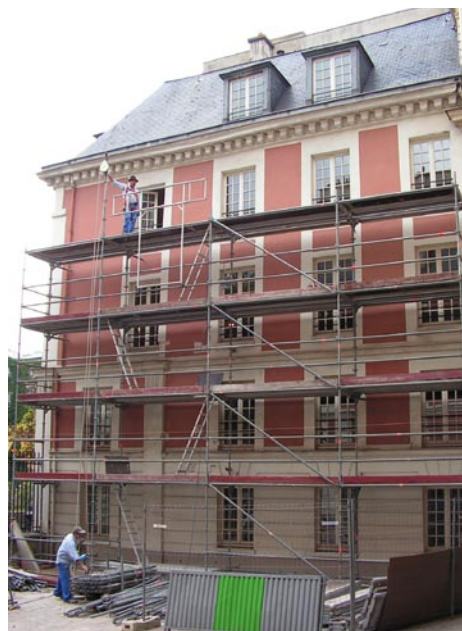
Die eingerüstete Fassade des Westflügels während der Bauarbeiten im September 2009
